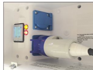
Stromzähler im Schaltkasten
